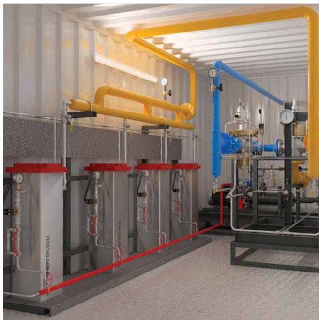
Испарительно-смесительная установка (высокое давление) для сжиженных углеводородных газов (пропан, бутан и их смеси) непрямого электрического подогрева тип ФЭМ 2400 ISU/SE/VD/K в контейнерном исполнении.
