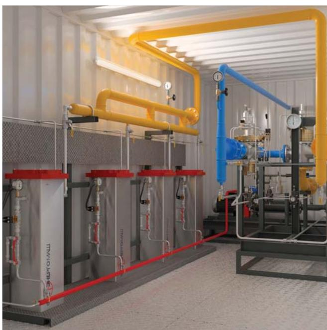
Испарительно-смесительная установка (высокое давление) для сжиженных углеводородных газов (пропан, бутан и их смеси) непрямого жидкостного (водяного) подогрева тип ФЭМ 1200 ISU/ZH/VD/K в контейнерном исполнении.
