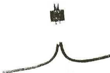
Рис.11. Подготовленные к сварке жилы кабеля с термитным патроном марки АС
